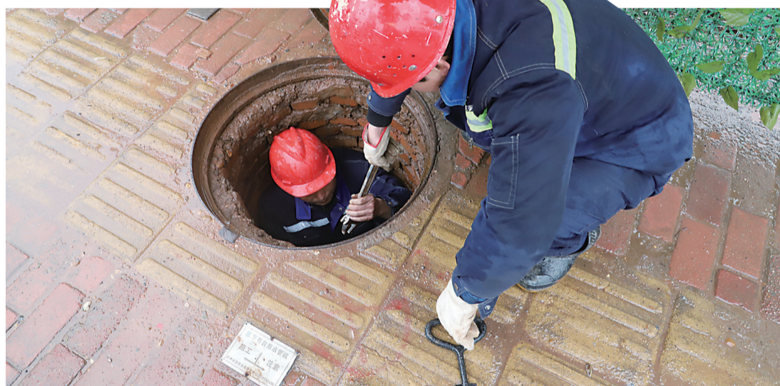
▲唐志辉、袁露明在抢修现场
