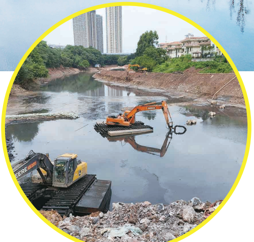
龙母河治理现场。荷塘区河长办供图
