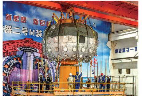
中核集团核工业西南物理研究院的工作人员在安装调试中国环流器二号M装置进行真空室吊装作业(2019年9月28日摄)。新华社发(中核集团核工业西南物理研究院提供)
