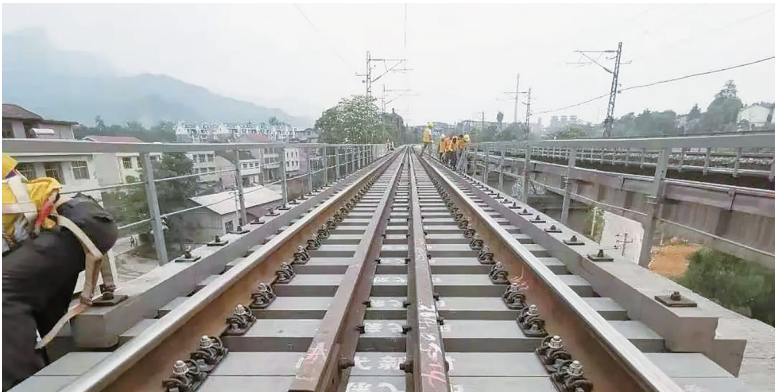
一桥梁完成复合材料轨枕更换完成。 企业供图
