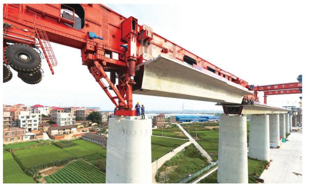
6月22日,中铁十一局集团建设者将一台1000吨箱梁架设在福厦高铁湄洲湾跨海大桥上,标志着我国首台1000吨级高铁箱梁运架一体机成功投入使用,我国高铁装备制造和施工水平获得重大突破。
