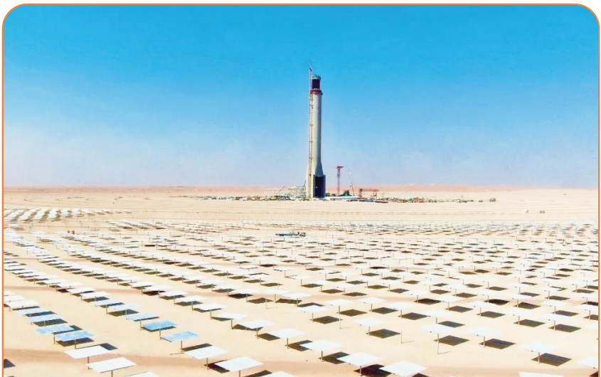
安装中的MSR(塔顶集热器) 受访企业供图
