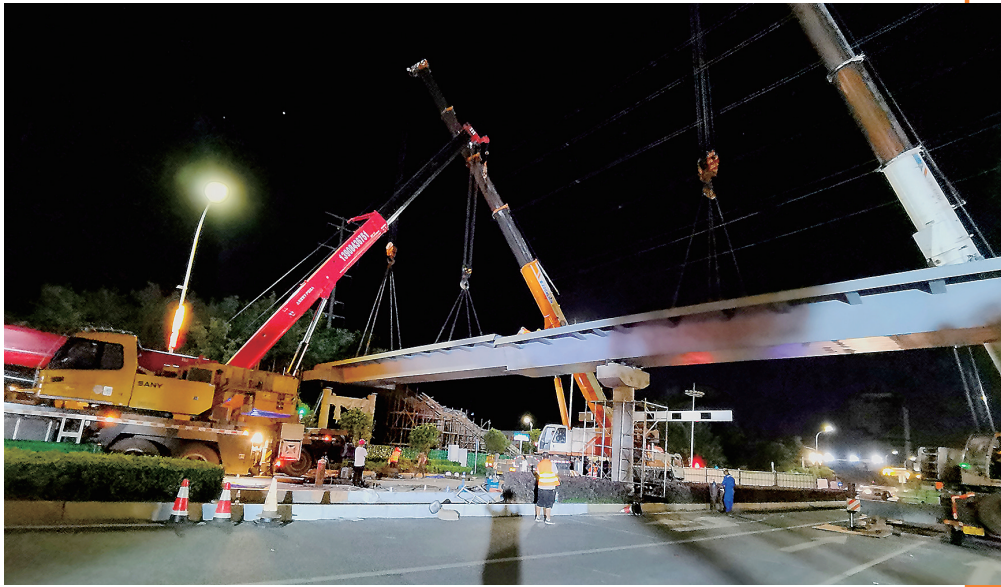
云龙大道(洞株路株洲段)快速化改造项目1号人行天桥整体吊装现场 通讯员供图 株洲日报记者 吴楚 通讯员/李林
