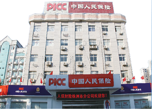
▲人保财险株洲市分公司大楼
