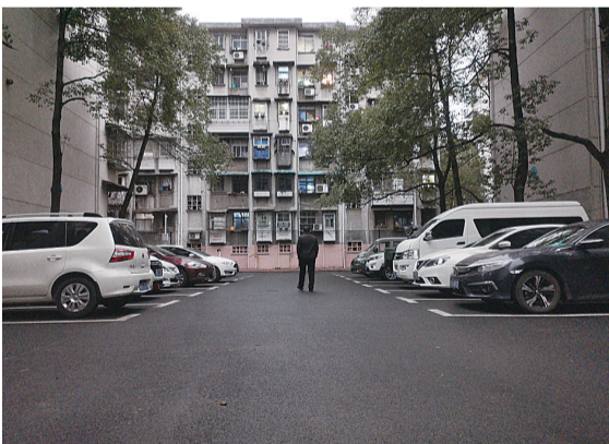
▲经改造后,滨江一村小区的环境大幅提升 记者 戴凇 摄
