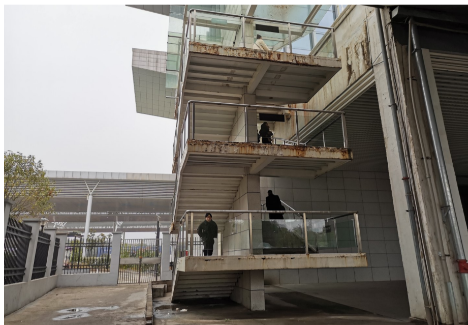
▲旅客从一楼爬楼梯到二楼进站口 记者 姚时美 摄
