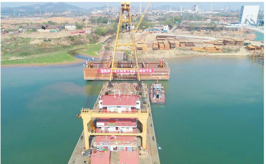
▲清水塘大桥结构形式为双层钢桁架拱桥,全长约2.8公里 通讯员供图
