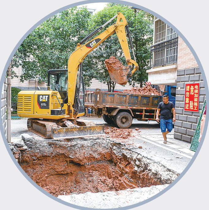
一老旧小区加装电梯开始施工。
