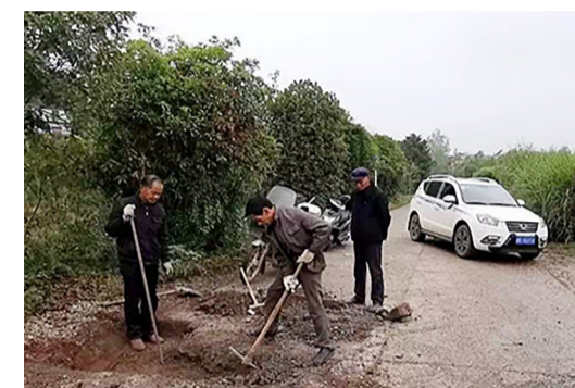
▲工作人员在现场施工 记者 周嵩 摄
