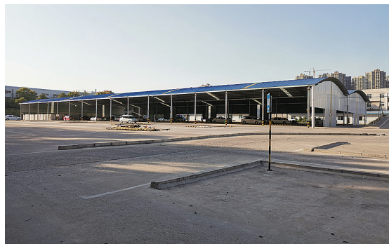
▲新丰达驾校搭建的钢结构棚子 记者 姚时美 摄
