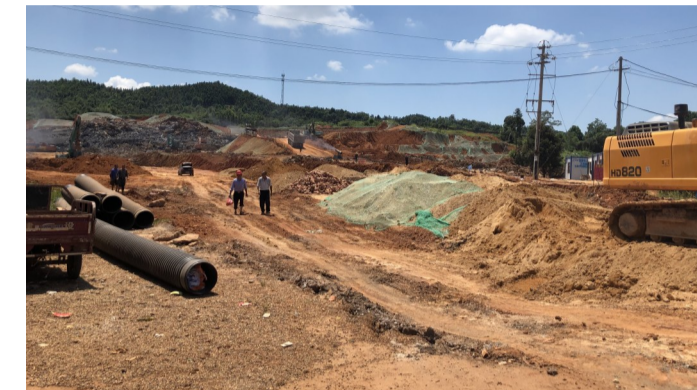
▲正在施工的H6地块项目 记者 周嵩 摄
