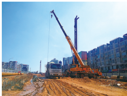
▲烈日下的响石广场改造工程工地,施工在火热进行 记者 李卉 摄
