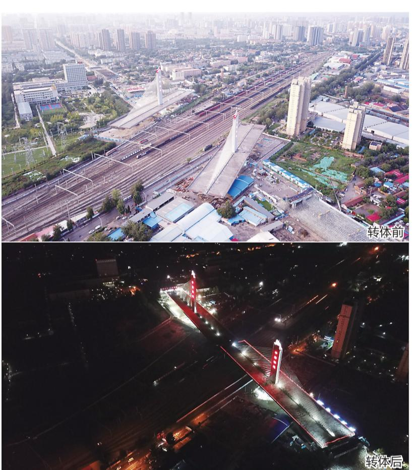
依靠支撑转体的“轴心”——转体球绞,30日凌晨,一座巨型桥梁在京广铁路上空成功完成转体,转体重量和跨度均创造了新的世界纪录。
