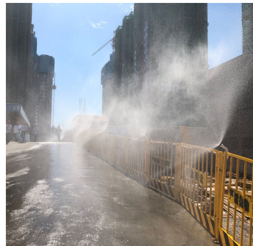
▲建筑工地使用喷淋设备,有效防治扬尘 记者 周嵩 摄
