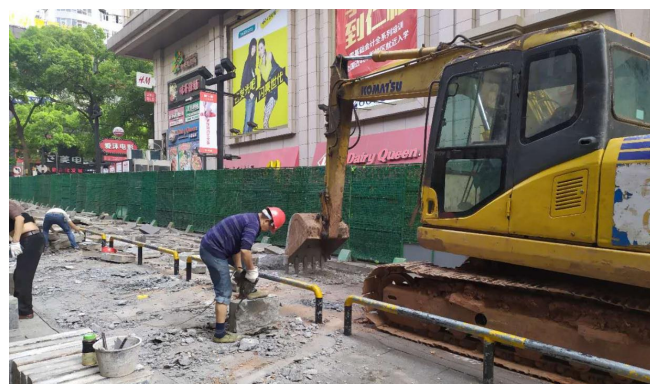
▲施工现场 通讯员供图
