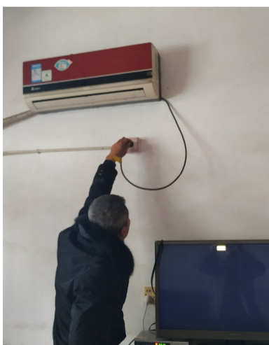
▲空调被烧坏,接电没显示亮灯 图片均为记者 姚时美 摄
