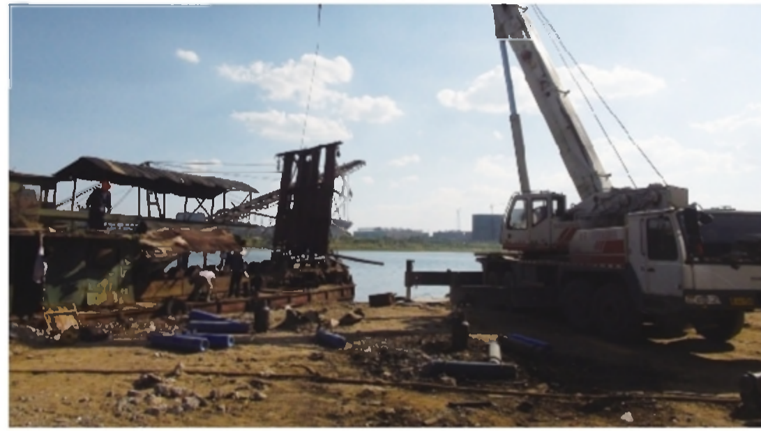
拆除非法采砂船。通讯员/易卫 摄
