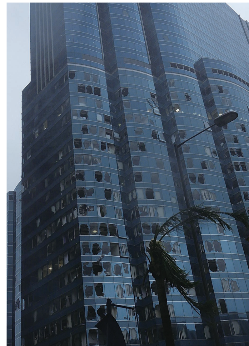
▲位于香港九龙半岛红磡海滨的一座写字楼,窗户玻璃破碎严重(9月16日摄)
