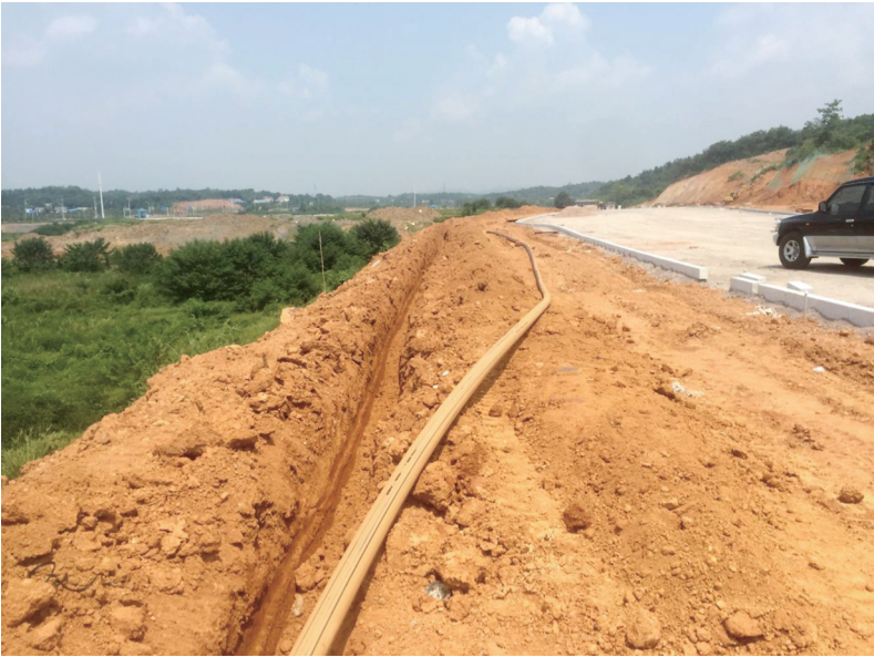
▲管道已不能使用,工人将其抽出
