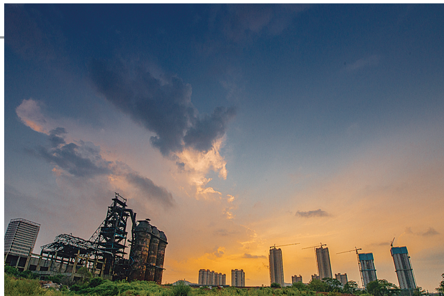
▲正在拆除的钢厂和拔地而起的新社区 记者 吴琦 摄
