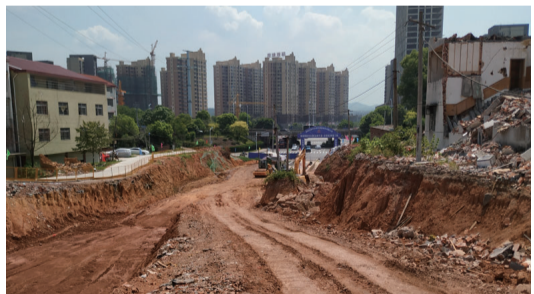
▲新文化路施工现场,老路被挖断了 记者 姚时美 摄
