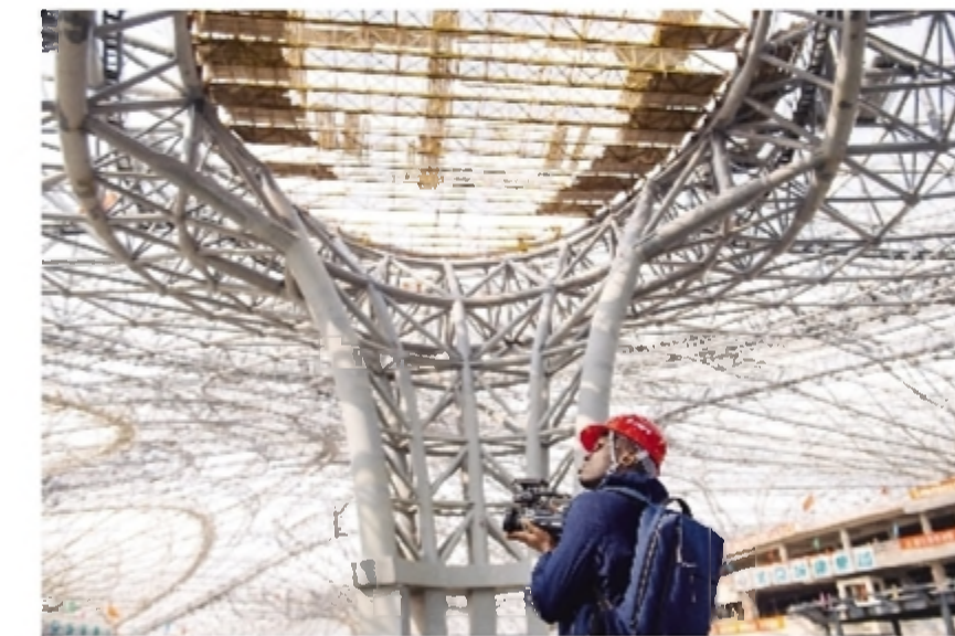
10月16日,南京广电集团记者阿曼特在北京新机场建设工地采访拍摄。
