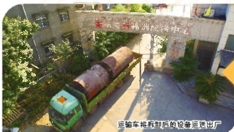
设备拆除进行时
